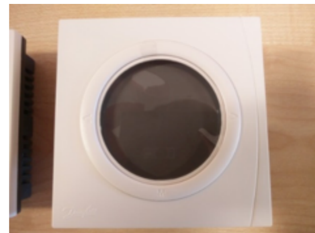
Põrandaküttetermostaat san.ruumis Tootja: Danfoss
